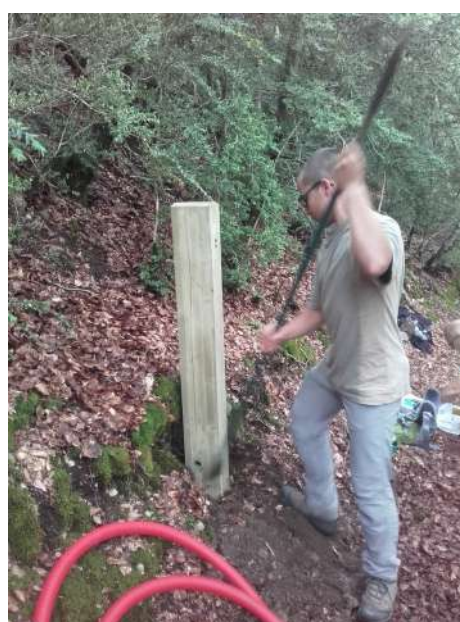
Pose d'un éco-compteur
