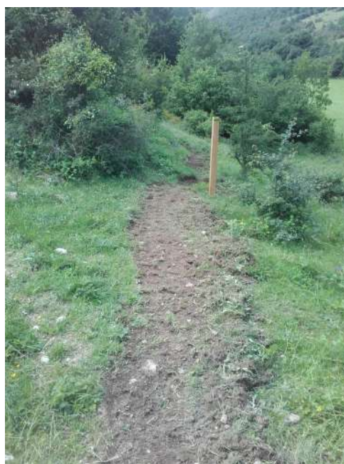
Chantier de Boussière : exemple de travaux sur la partie nord.
